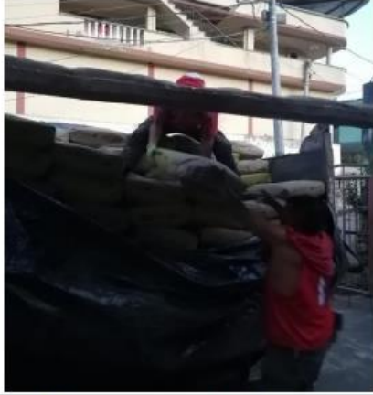
Foto 3. Descargue de cemento gris de 50 kg
